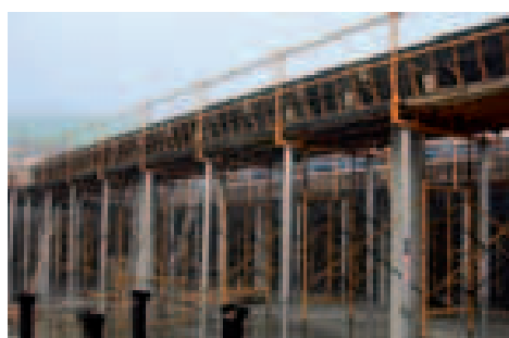
Ejecución de vigas de cuelgue con encofrado RAPID apeado con Cimbra G
