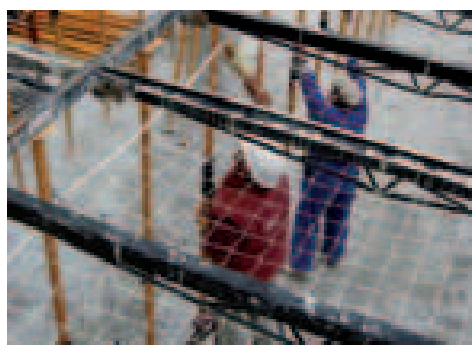
Montaje de Redes bajo forjado para la posterior colocación del tablero
